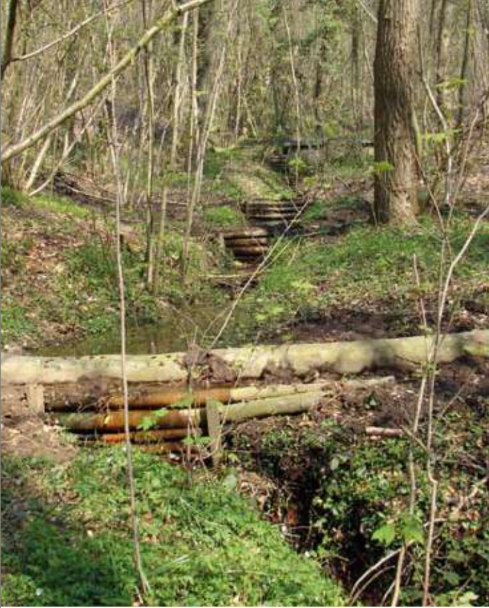
Mise en place de seuils dans un ruisseau forestier de la propriété départementale du Mont Noir. Photo B. Toussaint
