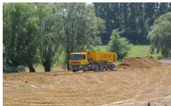
Remblaiement de zone humide. Photo : T. Cornier
